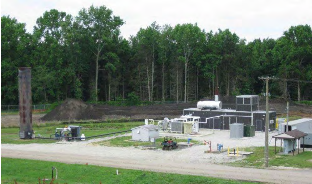
Рисунок 3-3. Будівля установки утилізації ЗГ потужністю 1.6 МВт на базі поршневого двигуна (компанія DCO Energy)
