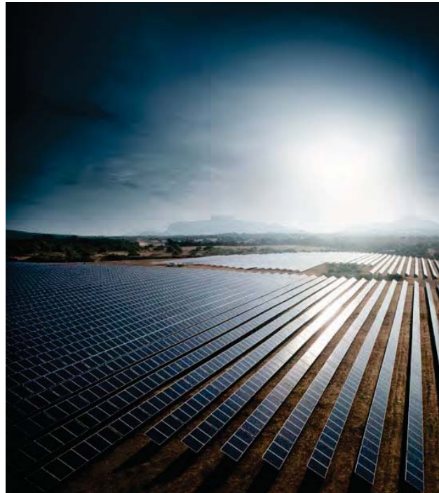
Рисунок 3-4. Типова сонячна установка потужністю 1.0 МВт на базі нерухомих модулів з кристалічного кремнію
