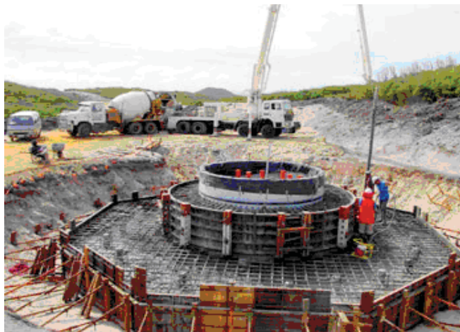
Рисунок 3-2. Будівництво типової розширеної до низу основи
